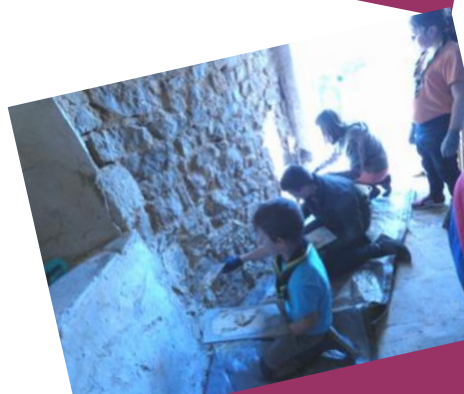
Chantier à Talleepied
